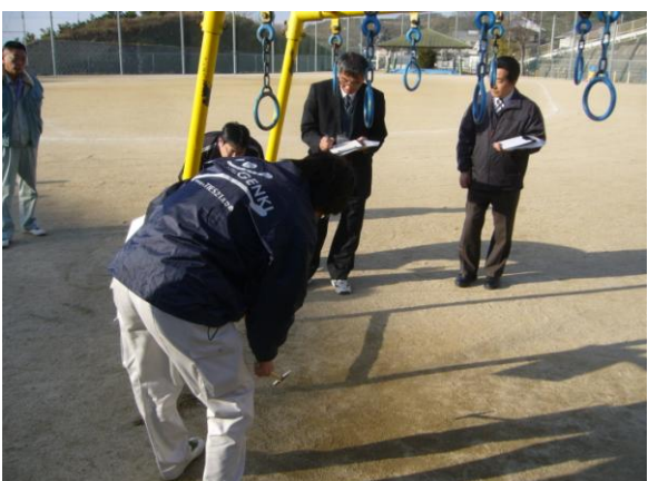
実際の点検注意箇所 01
