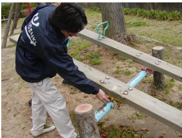
実際の点検注意箇所 02
